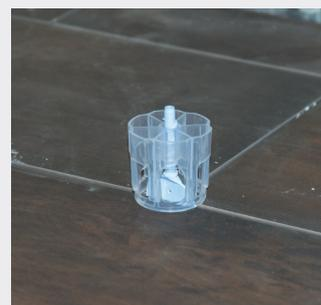
Installation der linearen Nivellier Vorrichtung.
