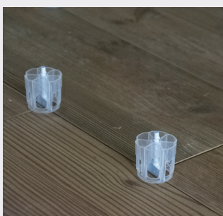
Установка т-образного уравнивателя
