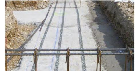
Separador lineal muy robusto y resistente, a unir longitudinalmente con un encaje para haber longitudes variables. La nueva forma permite de conciliar altísimas prestaciones técnicas y optimizar los costes.
