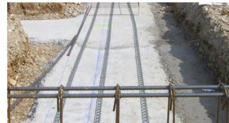
Distanziatore lineare estremamente robusto e resistente, unibile longitudinalmente con un semplice incastro per ottenere lunghezze variabili. La nuova forma permette di coniugare elevate performance tecniche alla ottimizzazione dei costi.
