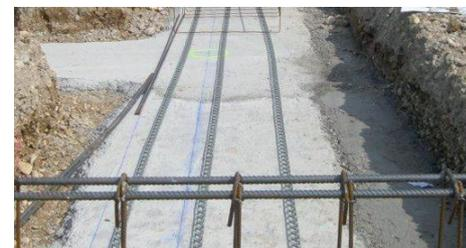
Распорка очень прочна и устойчива. Распорки можно удлинить простым соединением. Новая форма позволяет сочетать высокие технические характеристики с оптимизацией затрат.
