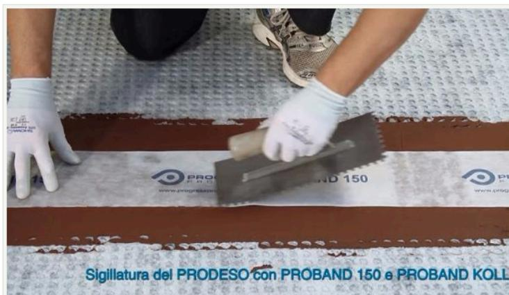
Se ne sconsiglia invece l'applicazione su guaine bituminose, per impermeabilizzare superfici calpestabili e lasciate a vista, come lastrici solari di copertura o aree esterne, su coibentazioni a tetto rovescio realizzate con pannelli isolanti o massetti alleggeriti.
