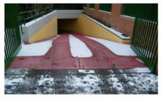
Un altro esempio è <u>Rete per esterni di THERMOEASY</u> composta da pannelli in rete di fibra di vetro che supportano i cavi riscaldanti in Fibra di Carbonio rivestiti con siliconi speciali. Grazie all'apposita sonda per il rilievo dell'umidità e temperatura superficiale, l'impianto funziona automaticamente e solo quando è necessario.
