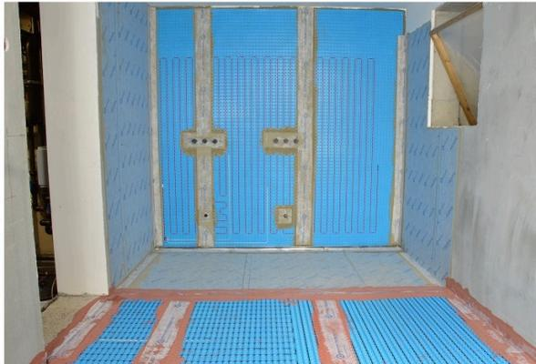
Tra i rilievi di essa è stato inserito il cavo elettrico scaldante. Per lo scarico sono state installate due canaline **PROSHOWER BASE L** nella lunghezza di 100 cm. Per donare al piatto doccia una moderna continuità dei materiali, si è scelto di personalizzare la canalina con la medesima piastrella del pavimento.
