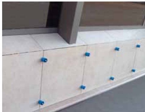
Installation der T-förmigen Nivellier Vorrichtung.
